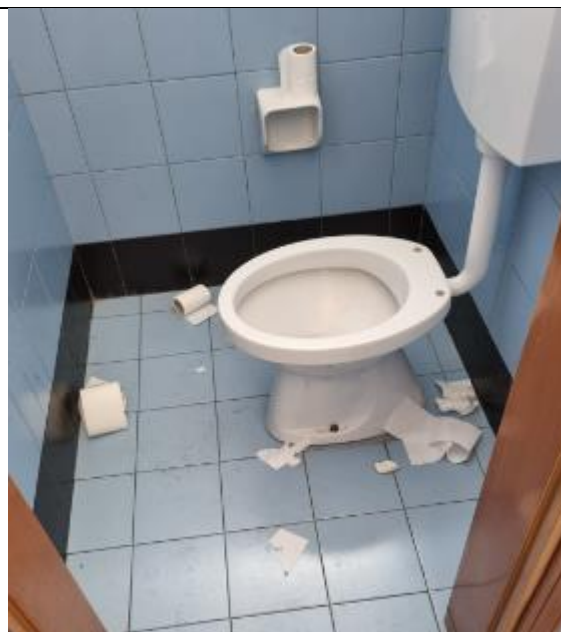
Foto n. 6 – Bagno femminile al primo piano (lato via Ofanto)
