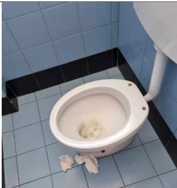
Foto n. 4 – Bagno femminile al primo piano (lato via Ofanto)
