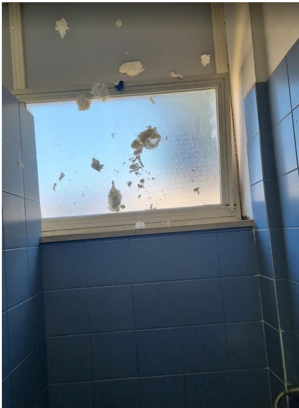
Foto n. 1 – Bagno maschile al primo piano (lato via Ofanto)
