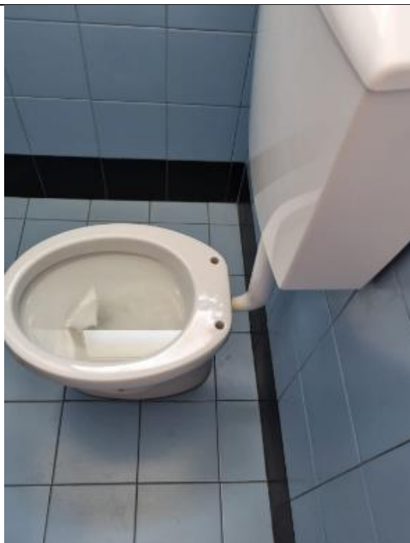
Foto n. 5 – Bagno femminile al primo piano (lato via Ofanto)
