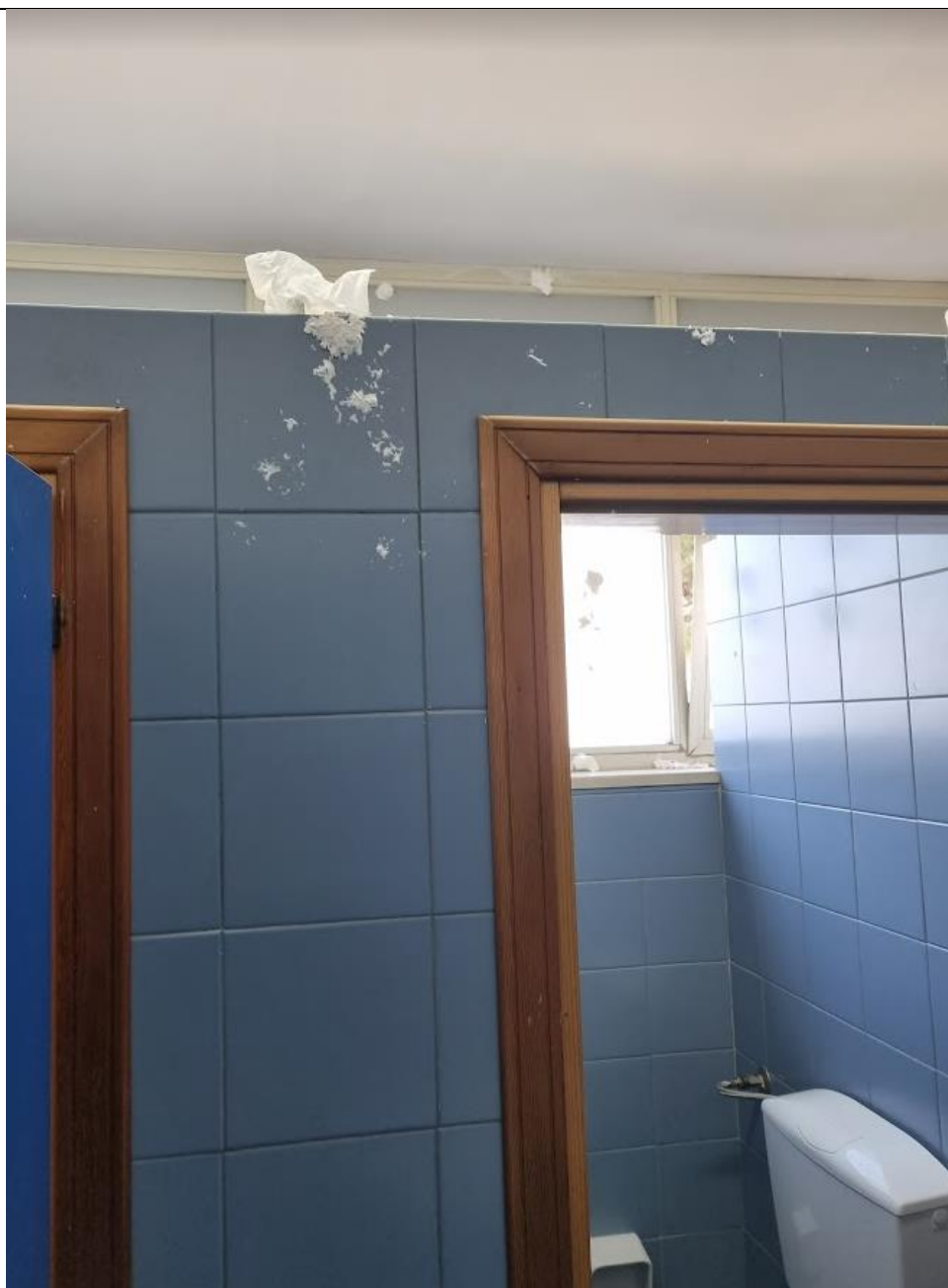
Foto n. 2 – Bagno maschile al primo piano (lato via Ofanto)
